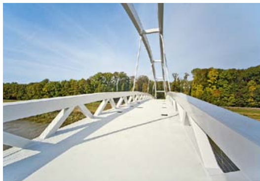
Lávka přes Moravu, foto: m-ARK
